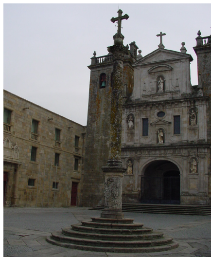
Figura 3.2 - Adro da Sé (fotografia actual)
