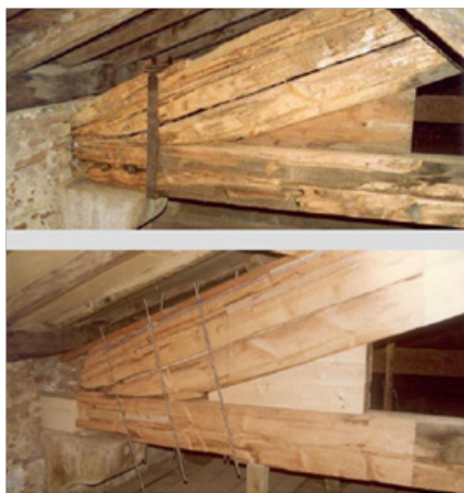
Figura 9.23 – Reparação, reconstituição e consolidação de zonas degradadas de peças de madeira em coberturas, com resinas injectadas, moldes de madeira, colagens, dispositivos de ligação, aparafusadores (extraído de [14])
