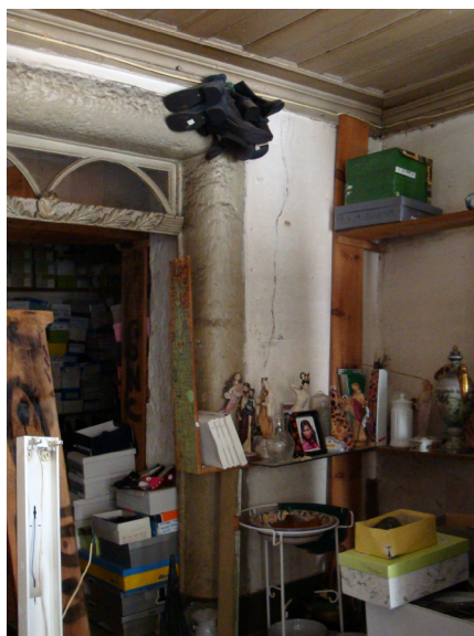
Figura 6.10 – Fendas verticais na zona de ligação ortogonal entre paredes de alvenaria de granito “média qualidade”
