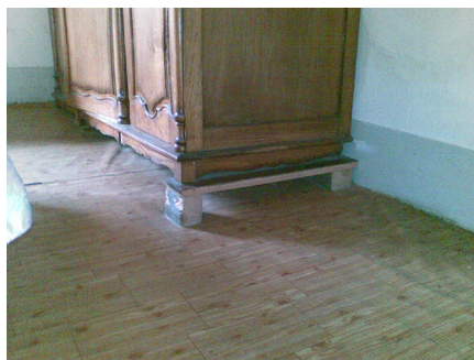
Figura 6.12 – Anomalias em pavimentos de madeira por deformabilidade excessiva
