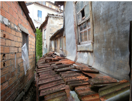
Figura 6.1 – Os lotes são densificados com construções acrescentadas na sua profundidade
