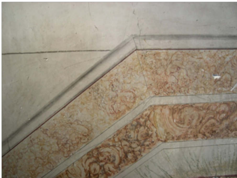
Figura - 9.? - Especial cuidado deve ser dado à reparação dos barramentos, com o seu simples brunido, com ou sem fingidos
