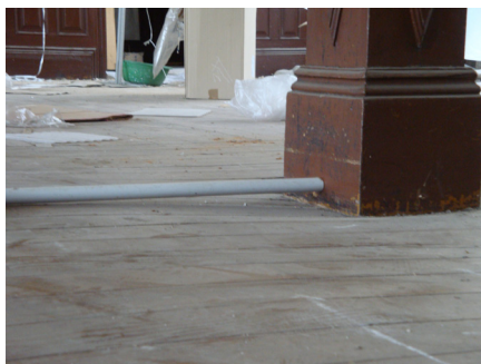
Figura 6.12 – Anomalias em pavimentos de madeira por deformabilidade excessiva
