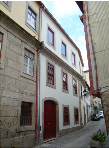
Figura - 9.? – Na reabilitação mais recente foram recolocados os revestimentos de argamassas, com vantagens diversas
