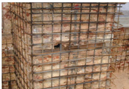
Reforço de alvenarias com lâmina de betão projectado, (extraído de [13]): 9.14.1 Malha de armadura em varão
