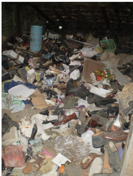
Figura - 9.2 - Diminuição da carga de incêndio, pseudo armazéns que são sótãos transformados em tal
