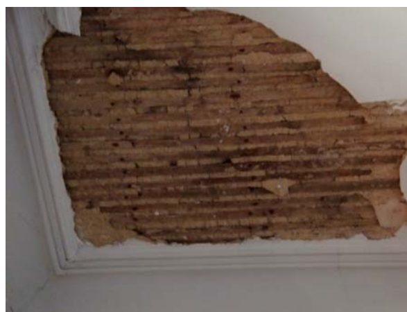
Fig. 6.30 | Destaque de estuque em tecto de esteira por humedecimento do fasquiado
