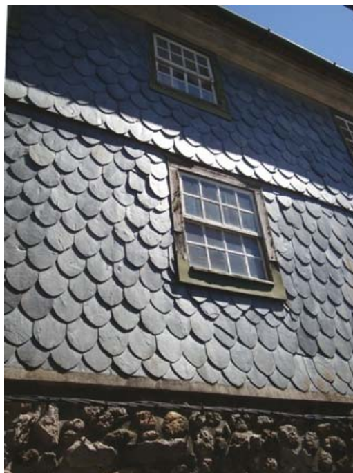
Fig. 9.68 | Os revestimentos de soletos de ardósia são usados também sobre paredes de pisos superiores leves e encontram-se em geral em bom estado
