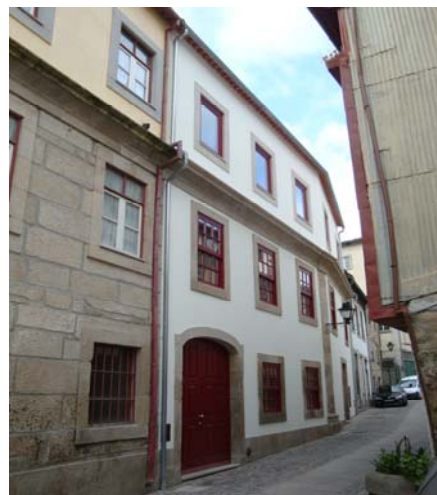
Fig. 9.64 | Na reabilitação mais recente foram recolocados os revestimentos de argamassas, com vantagens diversas
