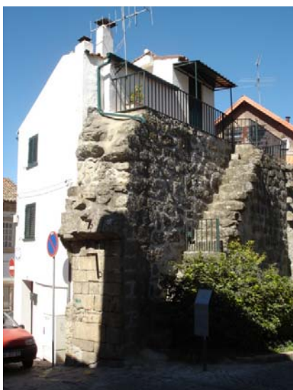
Fig. 5.52 | Casa adossada à muralha
