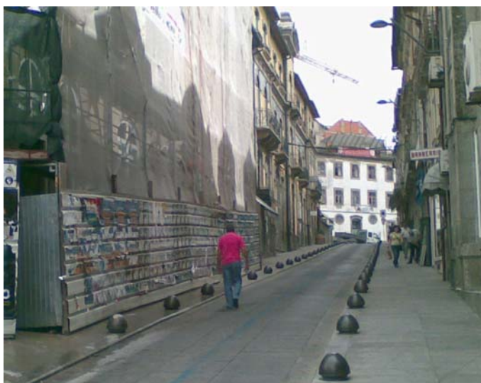
Fig. 10.3.a | Conflito via pública vs estaleiro – vedação
