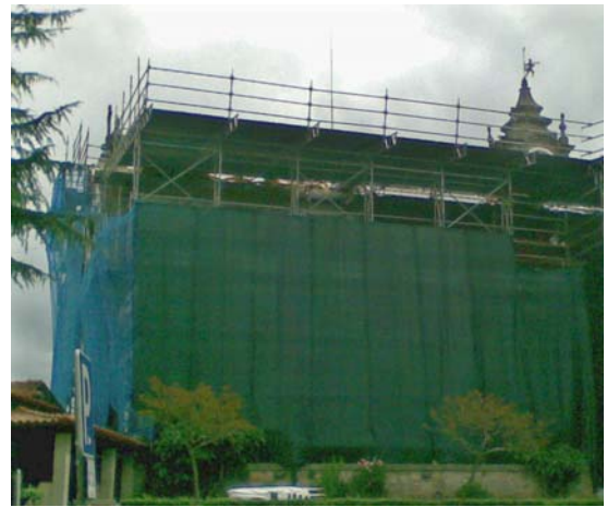
Fig. 10.1 .b | Cobertura metálica provisória
