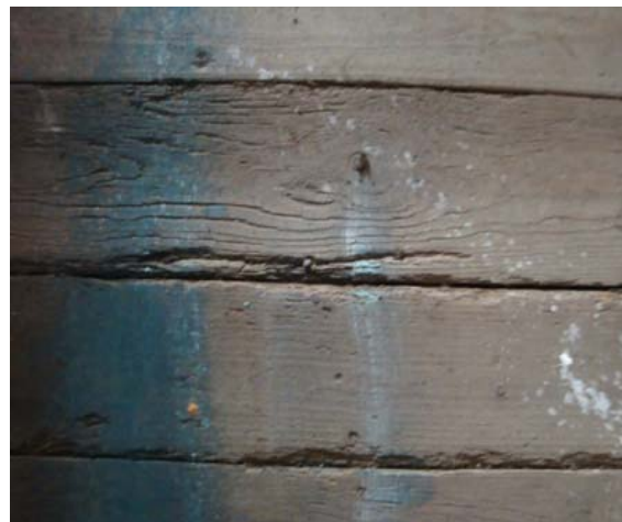
Fig. 9.82 | Características de um soalho que não tem recuperação, salvo se se justificar o elevado trabalho de desbaste
