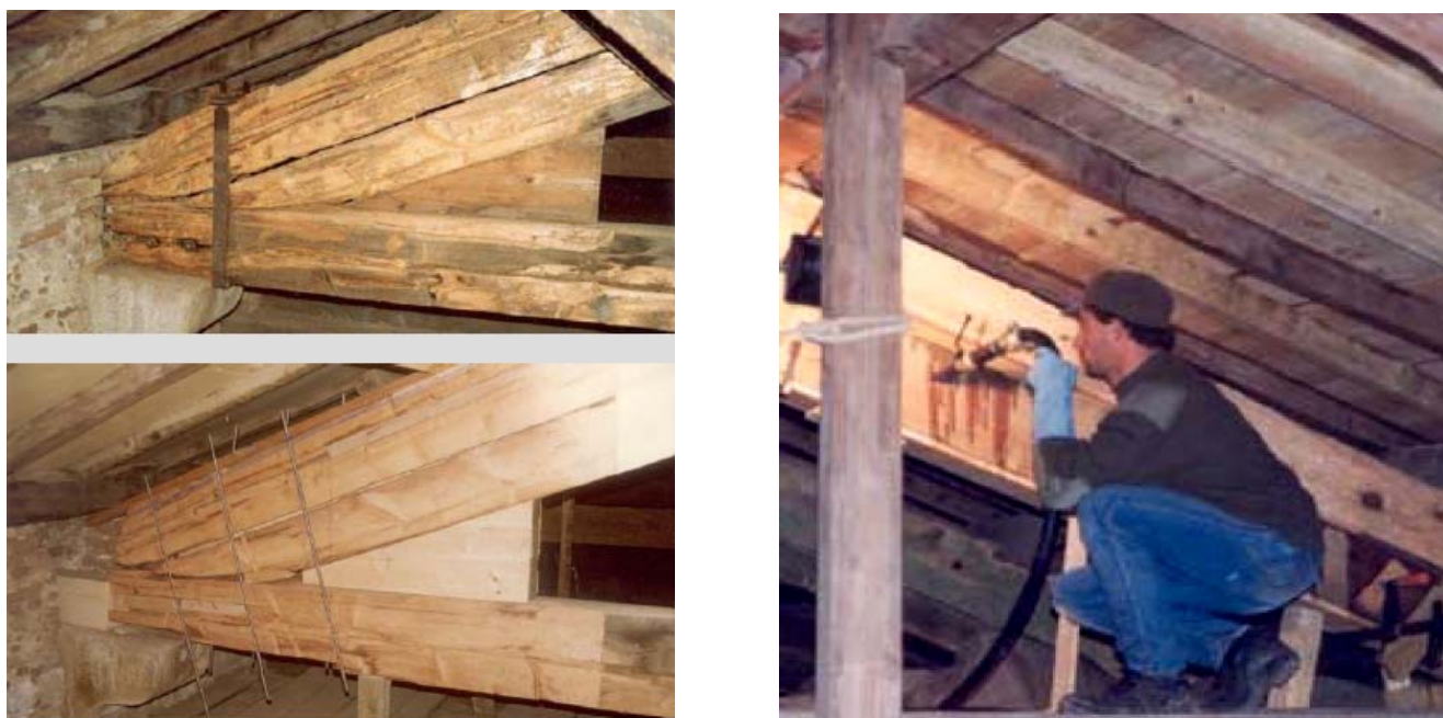
Figura 9.30 | Reparação, reconstituição e consolidação de zonas degradadas de peças de madeira em coberturas, com resinas injectadas, moldes de madeira, colagens, dispositivos de ligação, aparafusadores (extraído de [14])
