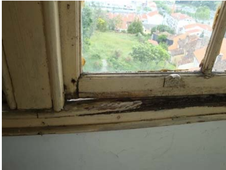
Fig. 6.27 | Os caixilhos de madeira são delicados e belos mas cujas patologias são fonte de outras deficiências na construção
