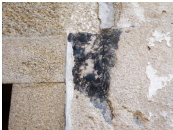
Fig. 6.9. b | Encaminhamento da fendilhação para a zona mais fraca associada à abertura de um vão
