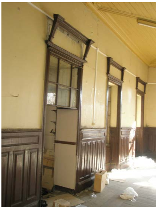
Fig. 7.8 | Interior de edifício do centro histórico de Viseu – valores das artes antigas a preservar
