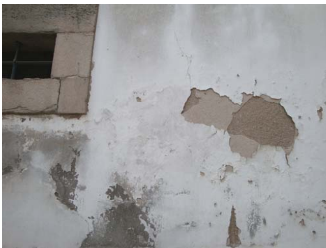
Fig. 9.63 | Reboco com problemas que repele o barramento de cal mas o esboço com cimento repele a tinta
