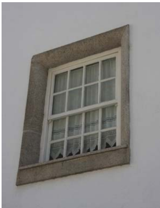
Fig. 9.71 | O caixilho de madeira é a solução tradicional e integrada com pinázios muito delgados
