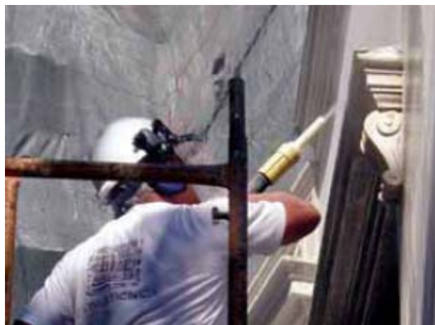
Fig. 9.11. b | Limpeza e tratamento de superfícies pétreas
