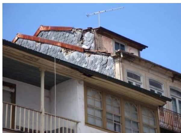
Fig. 6.33. b | Algerozes e tubos de queda são elementos frágeis e importantes
