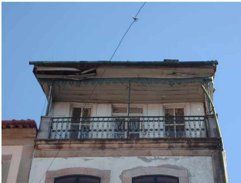
Fig. 5.25 | Telha balançado em andar recuado
