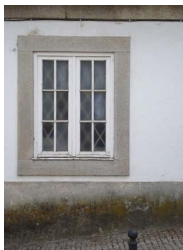
Fig. 9.88 | Peças de grande dimensão em socos são em princípio de revestimento para sofrer ataques como estes da imagem
