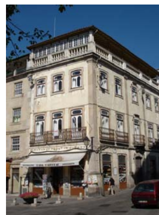
Fig. 5.45 | Prédio burguês, séc. XIX
