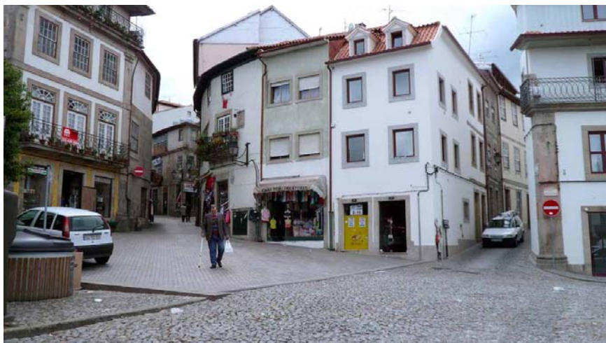
Fig. 8.27 | Entroncamento das Ruas de S. Lázaro e Direita no Largo Mousinho de Albuquerque
