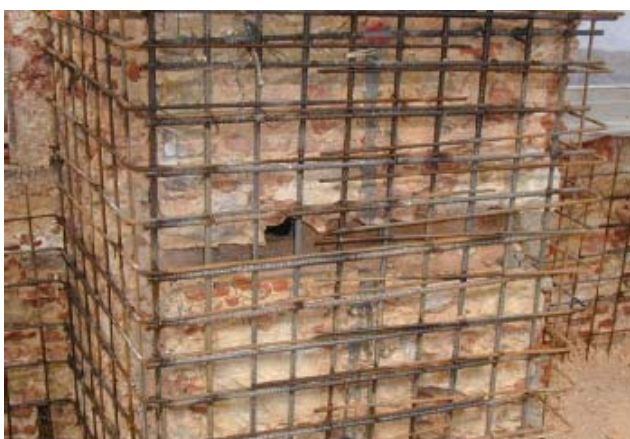
Fig. 9.21. a | Malha de armadura em varão
