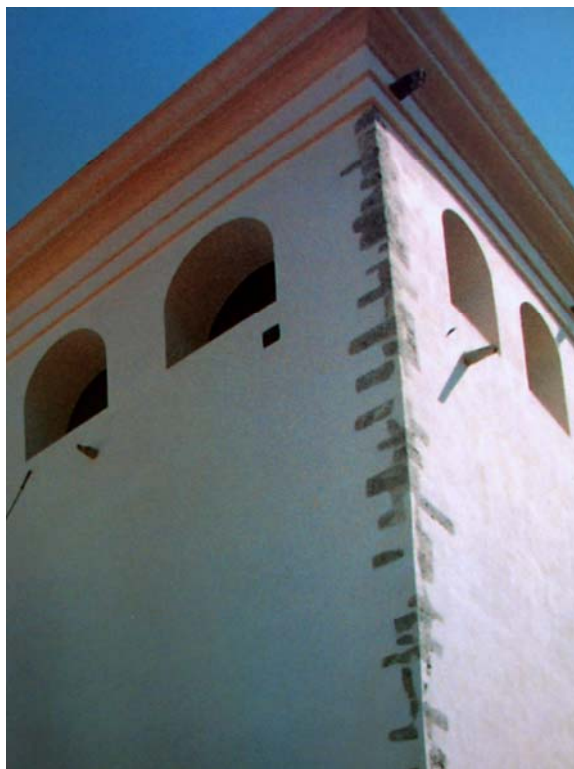
Fig. 9.62 | Argamassas de cal sobre alvenarias de pedra é uma solução correcta desde que bem aplicada (Torre do Relógio - Santarém)
