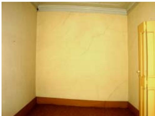
Fig. 6.9. a | Fendilhação oblíqua em parede resistente, com inflexão das fendas a 45º
