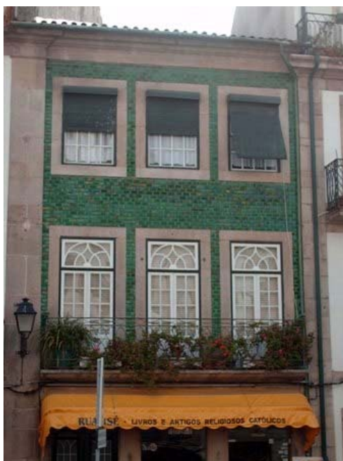
Fig. 9.65 | Os azulejos em Viseu são essencialmente da transição séc. XIX-XX por vezes em edifícios mais antigos
