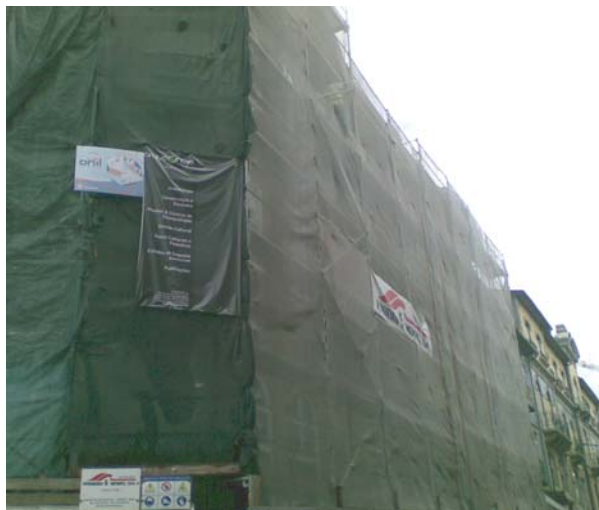
Fig. 10.2 | Andaimos e oleados de protecção
