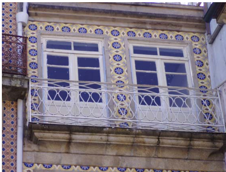
Fig. 5.30 | Revestimento a azulejo
