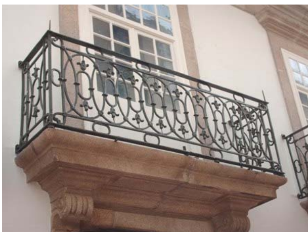
Fig. 9.79 | Guarda de aço laminado reabilitada
