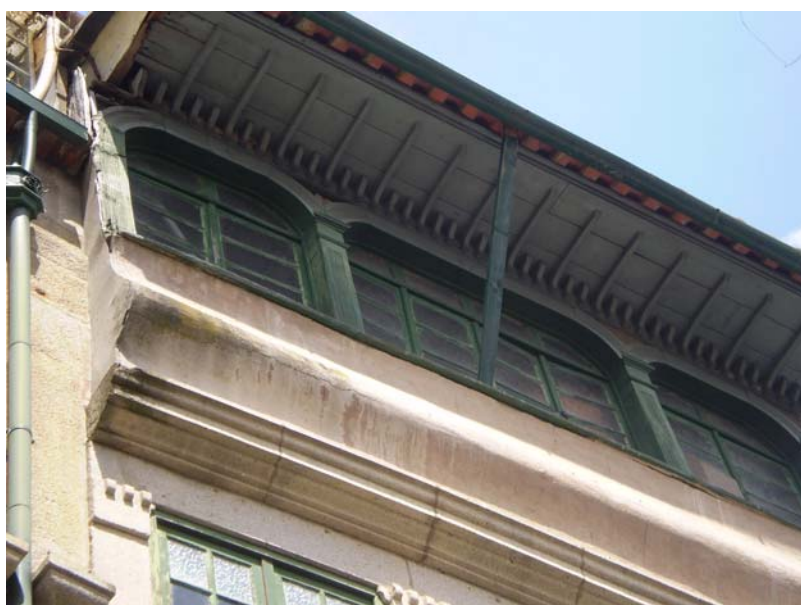
Fig. 5.26 | Balanço de telhado em madeira
