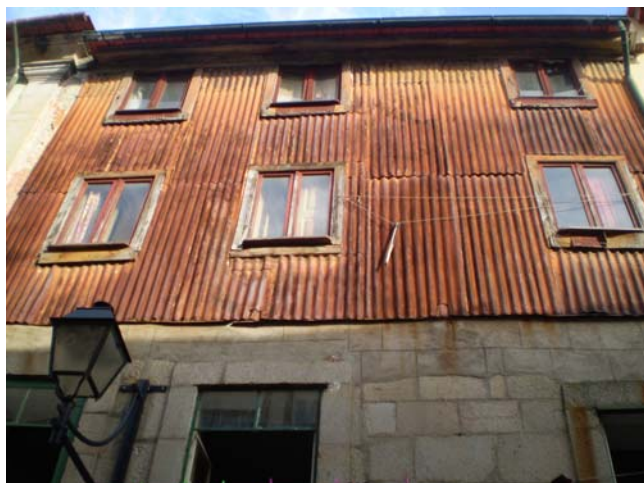
Fig. 5.28 | Revestimento exterior em chapa ondulada de zinco
