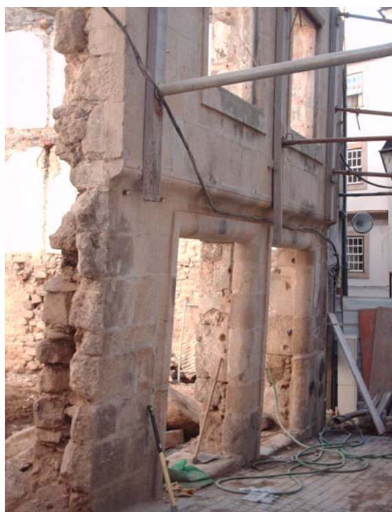
Fig. 9.1 | Renovação total do interior com aproveitamento da fachada de cantaria com desalinhamento perigoso
