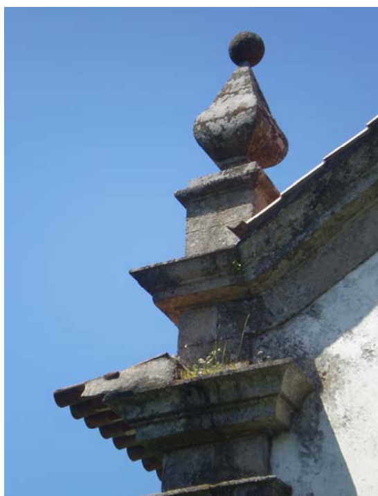
Fig. 9.53 | Todos os elementos horizontais salientes nas fachadas devem receber superiormente aplicação impermeabilizante
