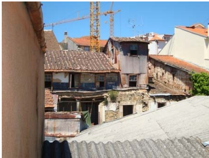
Fig. 6.16 | Acrescentos verticais e horizontais para o interior dos quarteirões dificultam ventilação e iluminação em pisos inferiores
