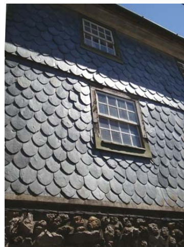
Fig. 5.29 | Revestimento exterior em escamas de ardósia
