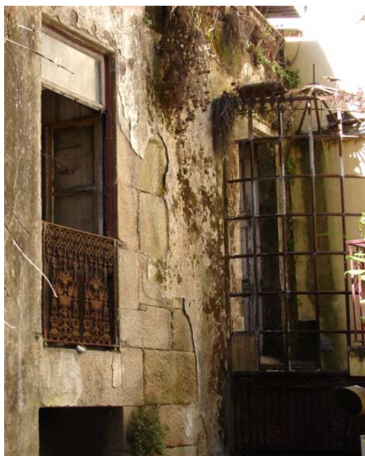
Fig. 9.73 | Estes caixilhos de aço apresentam perfis mais esbeltos e uma imagem adequada à idade dos imóveis
