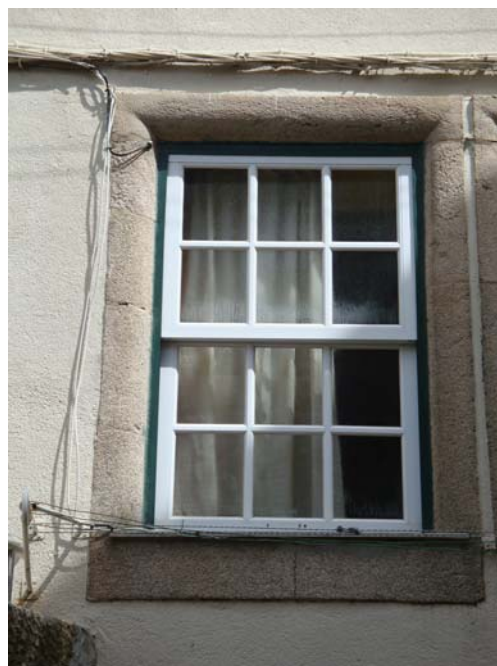
Fig. 9.72 | Hoje é possível realizar caixilhos em alumínio lacado com boa adaptação ao modelo antigo
