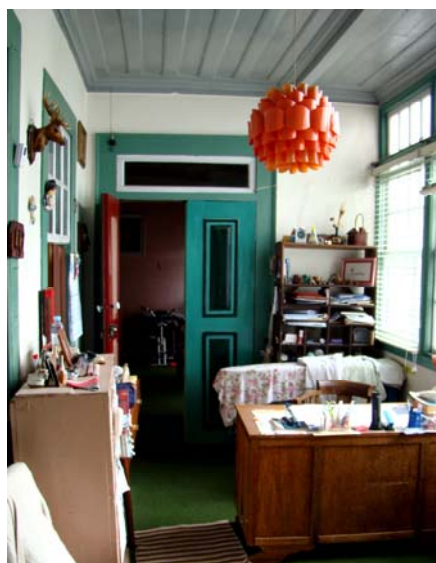
Fig. 9.84 | Tecto falso de tábuas pintadas, bem conservado em ambiente residencial
