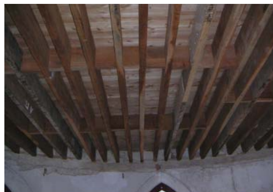
Fig. 9.38 | Exemplo de reforço com novos tarugamentos (extraído de [14])
