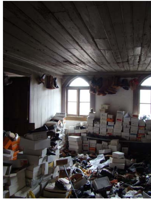
Fig. 9.50 | O mesmo fenómeno existe também em alojamentos
