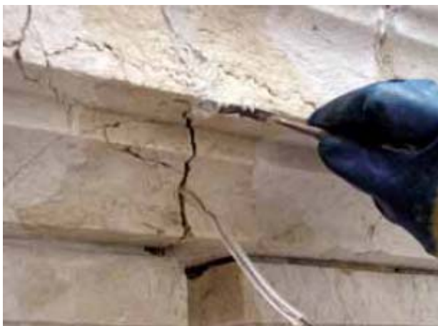
Fig. 9.11. a | Reparação localizada de elementos de cantaria
