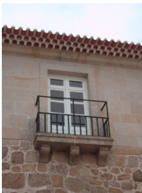
Fig. 5.48 | Beirado triplo
