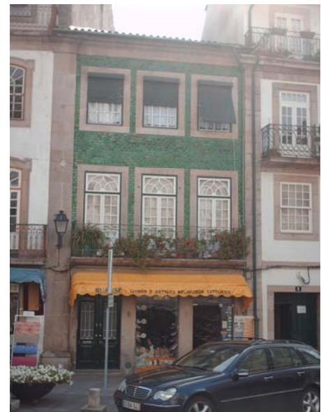
Fig. 2.11 | Prédio do séc. XIX
