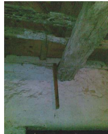
Fig. 9.43 | Pormenor da antiga ligação entre parede de alvenaria e pavimento
