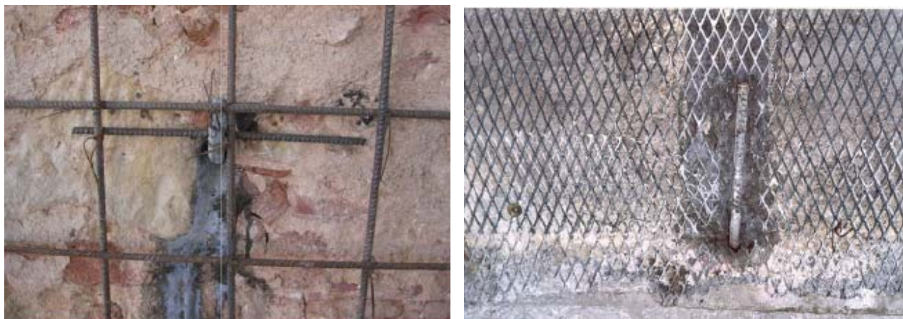
Fig. 9.20 | Exemplo da reparação de uma fenda com a técnica de recobo armado (adaptado de [21])
